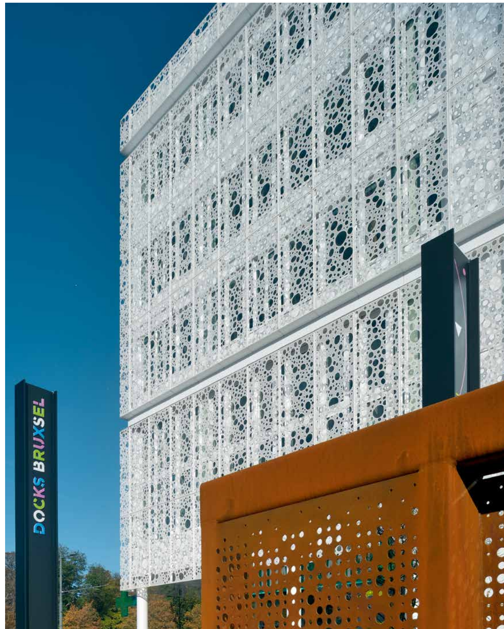
Sopra: i riferimenti organici e l'espressività artistica che caratterizzano il progetto di Art & Build si ritrovano anche nella reinterpretazione dell'acciaio, declinato in varie figure nei setti in Corten e nei brise-soleil degli uffici
